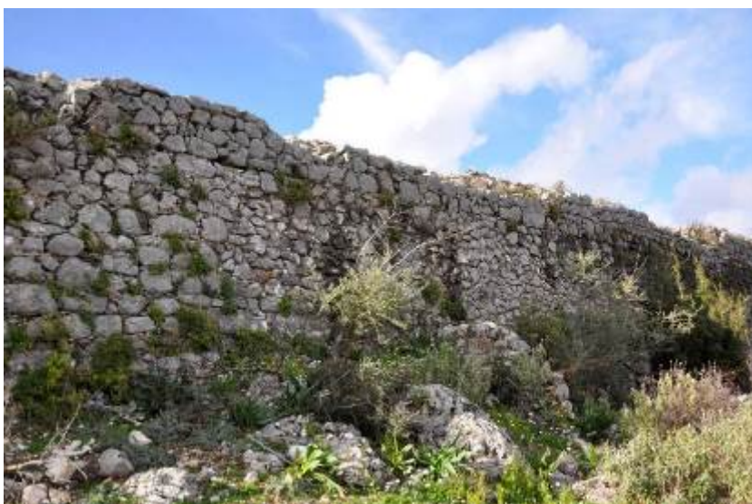
Εικ.10 Νοτιοανατολική (ΝΑ) εξωτερική πλευρά.
