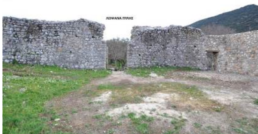
Εικ. 7 Νοτιοανατολική (NA) & δυτική (Δ) εσωτερική πλευρά: εσωτερική άποψη της πύλης και στα δεξιά το αποκατεστημένο τμήμα της δυτικής τειχοδομής κατά τις εργασίες του 2022.
