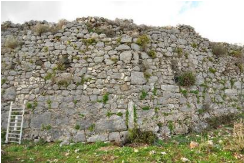
Εικ. 8 Νοτιοανατολική (ΝΑ) εξωτερική πλευρά.
