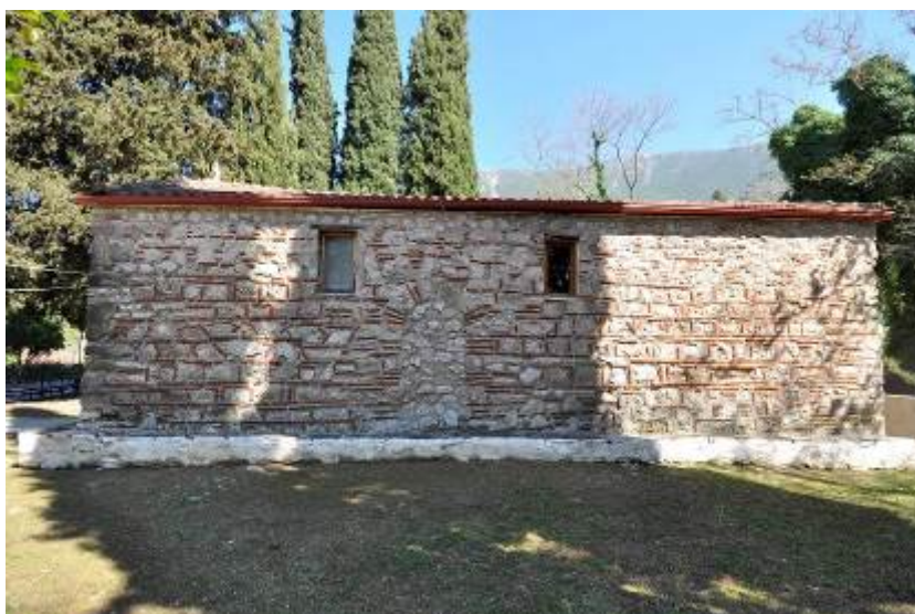
Εικ. 5 Νότια πλευρά με την τοιχισμένη θύρα.
