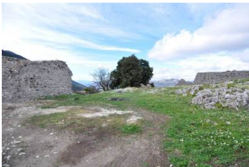
Εικ. 12 Δυτική (Δ) & Βόρεια (Β) εσωτερική πλευρά.
