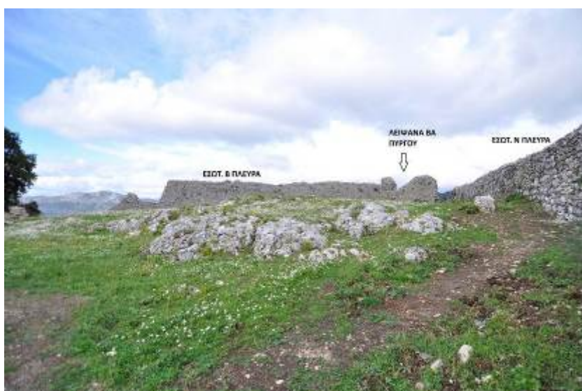
Εικ. 13 Βόρεια (Β) & νότια (Ν) εσωτερική πλευρά.
