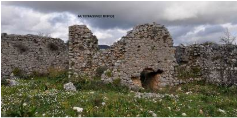
Εικ. 14 Τετράγωνος πύργος στη βορειοανατολική (ΒΑ) γωνία από το εσωτερικό του κάστρου.
